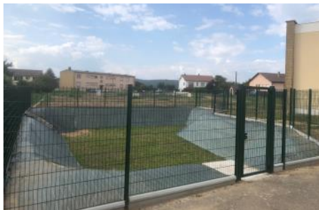
Un grillage sécurise le bassin d'infiltration d'eau.
