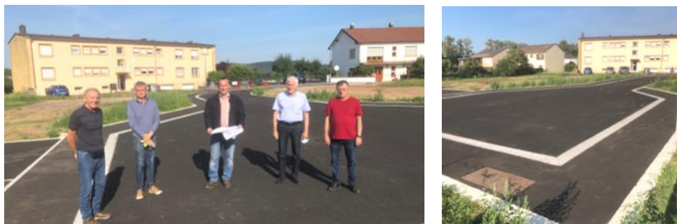
Une réunion de chantier hebdomadaire a permis de suivre les travaux.
