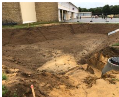
Un bassin de rétention des eaux a été créé pour récolter les eaux pluviales du lotissement
