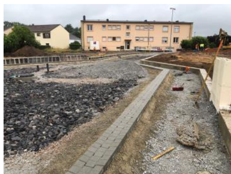
Un bassin de rétention des eaux a été créé pour récolter les eaux pluviales du lotissement
