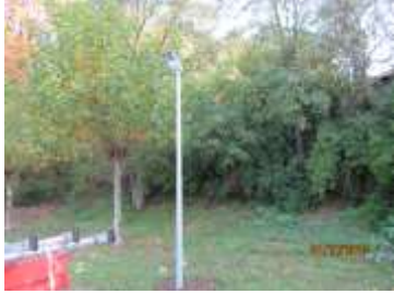
Remplacement d'un mât et installation d'une lampe Led au parc 1.
